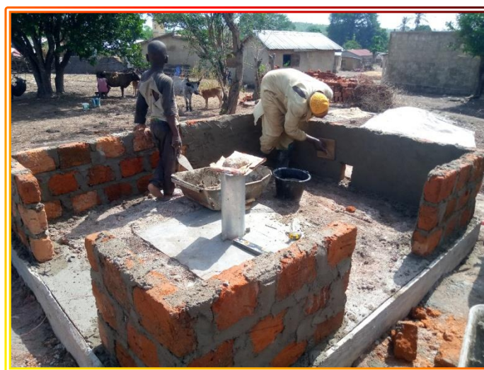
Construction des muretins de protection de la structure.
